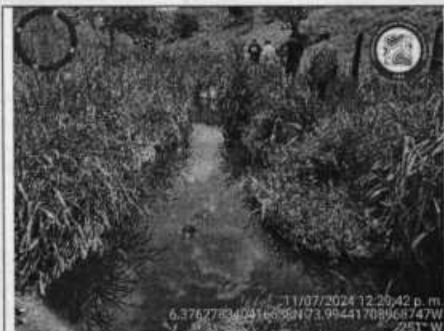
Fotografía 6: Condiciones del drenaje denominado "Aguas Claras"
