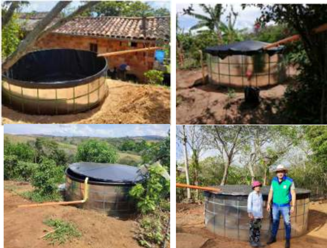
Registro Fotográfico 6. Sistemas de recolección de agua construidos en el año 2022 y 2023 por la CAS
