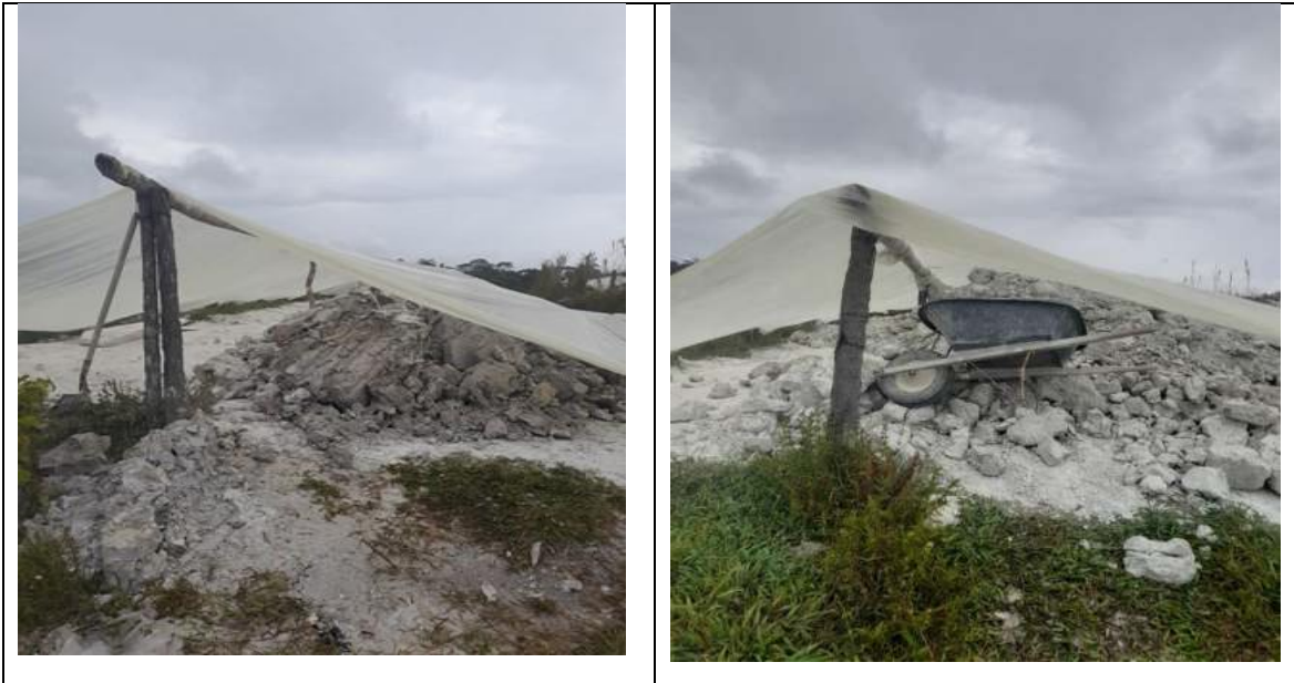
Fotografía 8. Patio de Acopio y/o Secado de Caolín N°3.
