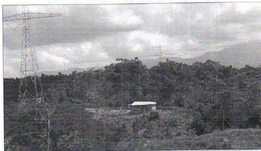
Fotografía 6. Vano entre torres 500-501, Fuente CAS 2020.
