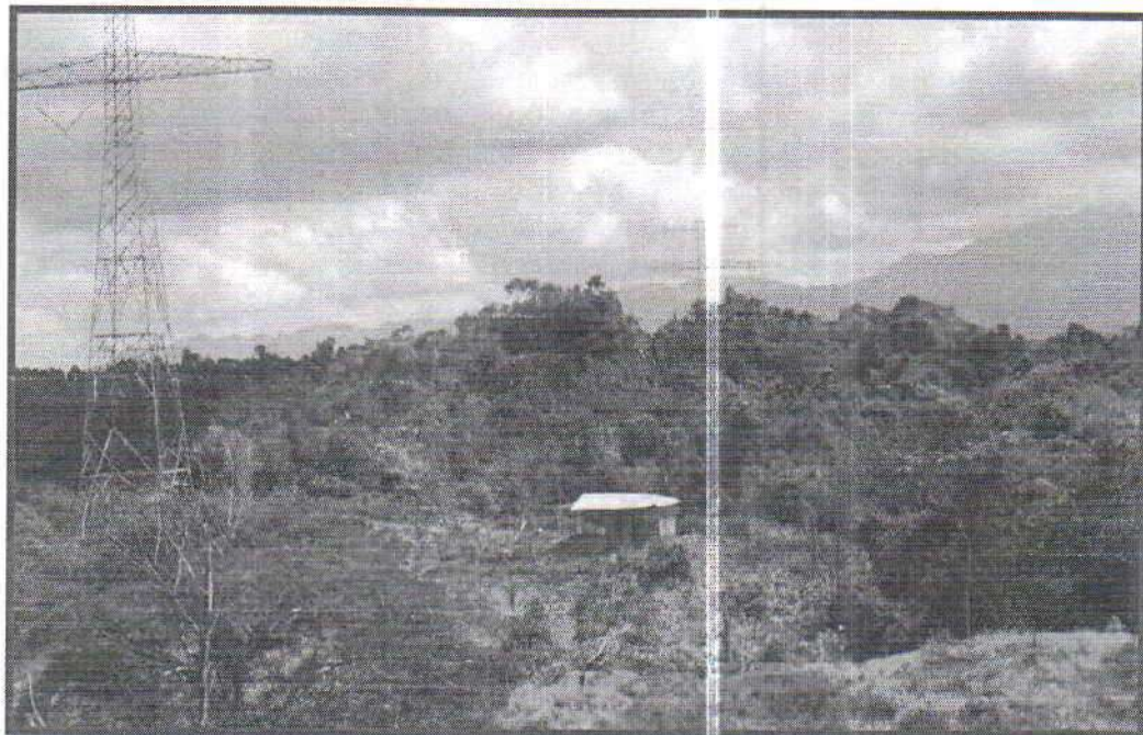
Fotografía 3. Vano entre torres 495-496. Fuente CAS 2020.
