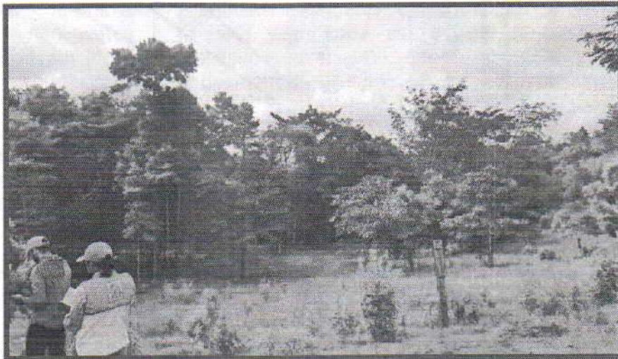
Fotografía 6. Vano entre torres 503-504, Fuente CAS 2020.
