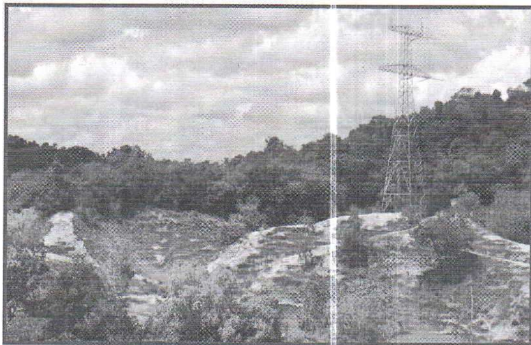
Fotografía 4. Vano entre torres 497-498, Fuente CAS 2020.
