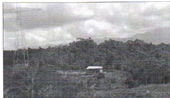
Fotografía 6. Vano entre torres 500-501, Fuente CAS 2020.
