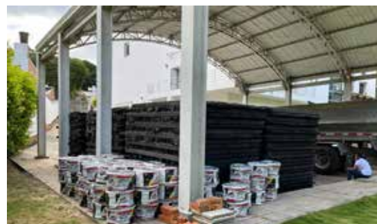
Inventario de kits de aislamiento de afloramientos de agua en Sede Central CAS – municipio de San Gil.
