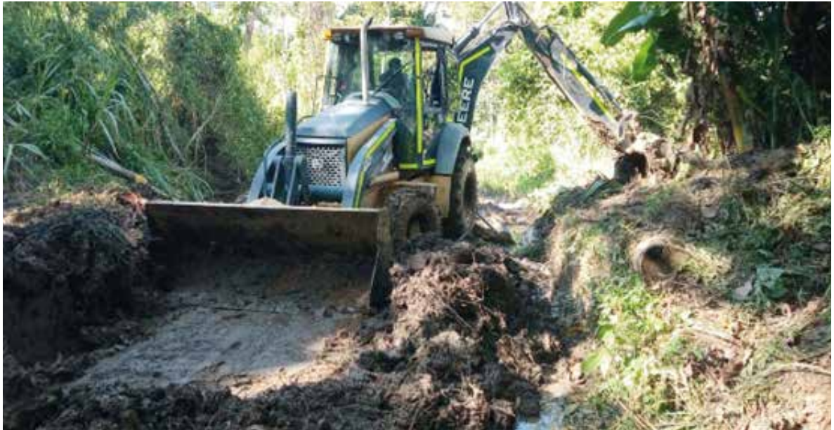
Con nuestro banco de maquinaria, atendemos los llamados de emergencia frente a deslizamientos y derrumbes, en los 74 municipios.
