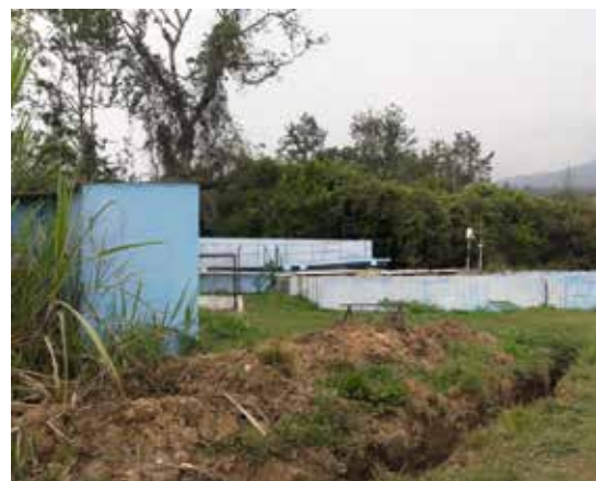
Planta de Tratamiento de Aguas Residuales PTAR – Municipio de Valle de San José.
