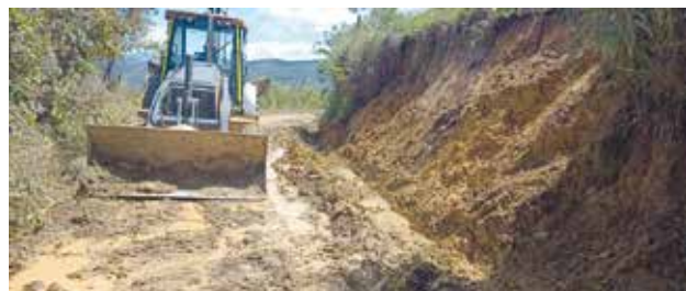
Atención emergencia por medio de préstamo de retroexcavadora - municipio de Gámbita.
