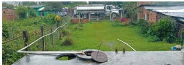
Suministro de agua por medio de carrotanque CAS - municipio de Suaita.
