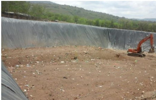
Compactación de residuos en el relleno sanitario EMPSACOL, San Gill, febrero de 2019.
