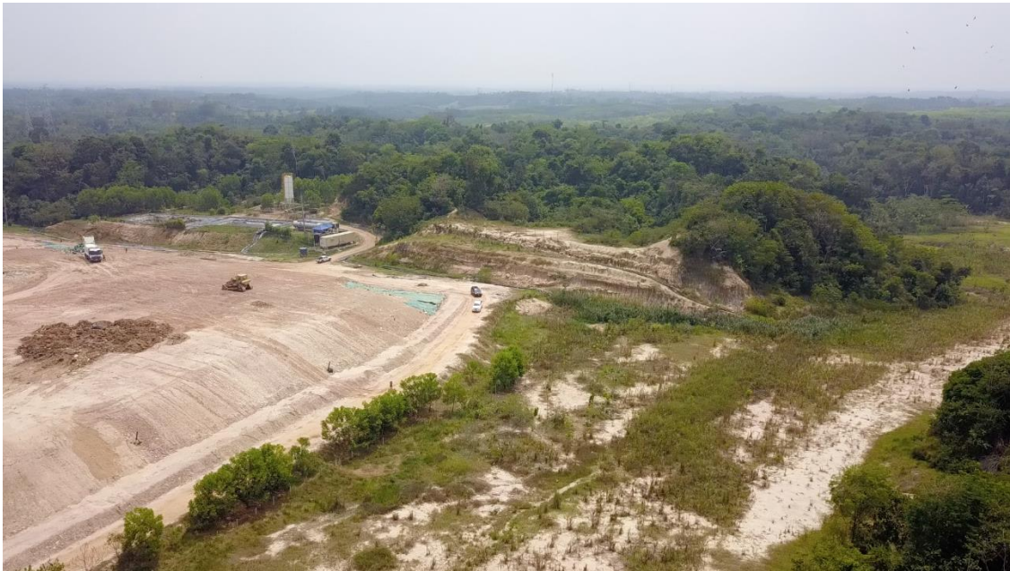
Fotografía 32. Relleno Sanitario Ecoparque Veolia.
