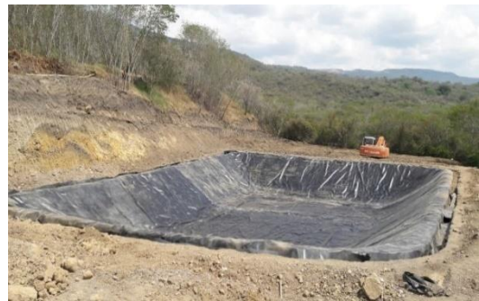
Impermeabilización de pondajes para tratamiento de lixiviados relleno sanitario EMPSACOL, San Gill, febrero de 2019.
