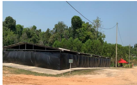
Sistema de tratamiento de lixiviados relleno sanitario ECOPARQUE VEOLIA antes REDIBA, Barrancabermeja, febrero de 2019.
