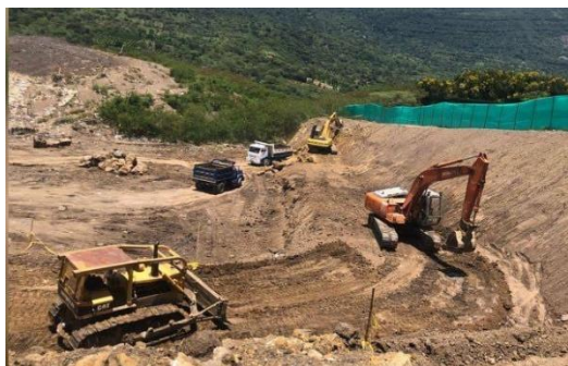
Construcción nueva celda relleno sanitario EMPSACOL, San Gill, febrero de 2019.
