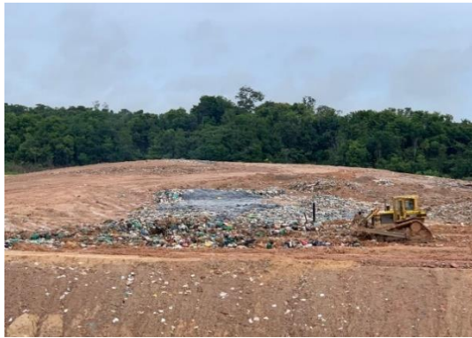
Frente de trabajo relleno sanitario ECOPARQUE VEOLIA antes REDIBA, Barrancabermeja, febrero de 2019.
