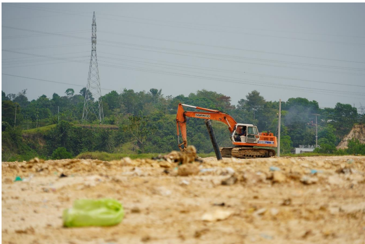
Fotografía 30. Relleno Sanitario Ecoparque Veolia.
