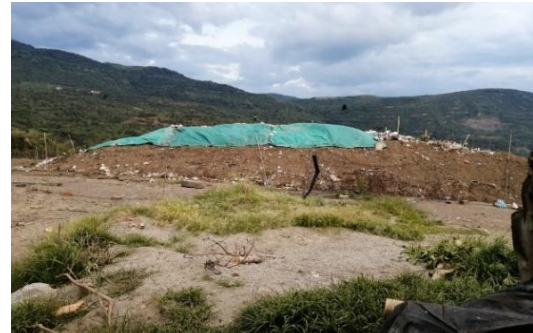
Labores de cobertura diaria relleno sanitario EMPSACOL, San Gill, febrero de 2019.
