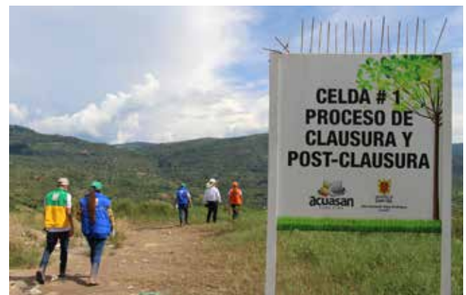
RELLENO SANITARIO – SAN GIL
