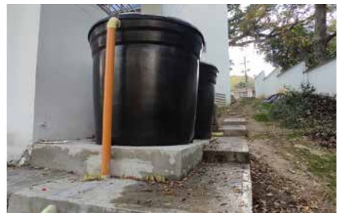
SISTEMA DE RECOLECCIÓN DE AGUAS LLUVIAS - CAS
