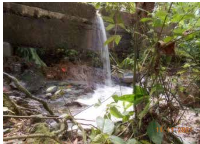
SEGUIMIENTO A VERTIMIENTO AGUAS RESIDUALES MUNICIPIO DE BOLÍVAR.
