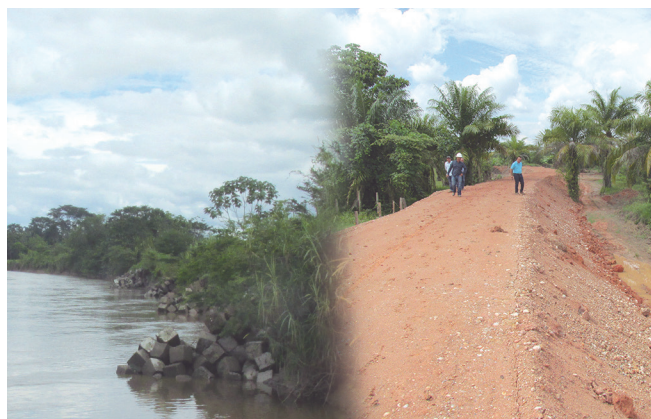
Espolones – Terraplén Río Sogamoso Sector Candilejas, municipio de Barrancabermeja.
