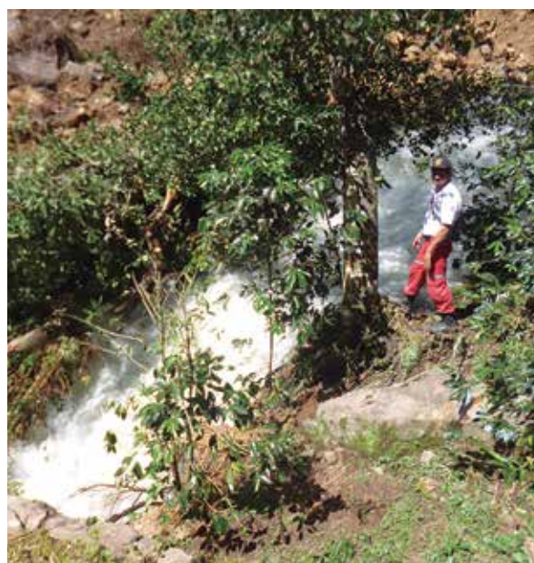
Atención y asistencia técnica al represamiento de la quebrada Guachavita (Coromoro) provocado por deslizamiento
