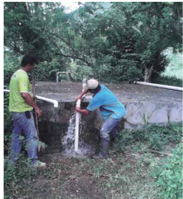
Obras de Suministro de agua - Cabrera.
