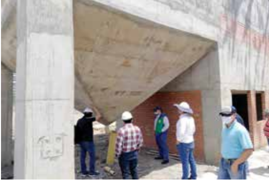
Detalle de avance de obra PTAR Curití.
