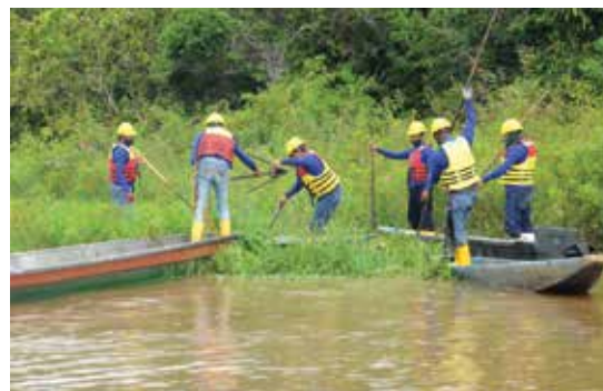
Las labores de remoción de material vegetal de especies invasoras, es realizada con trabajadores del sector.
