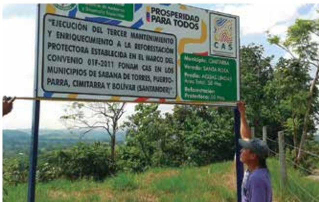
Instalación de valla, predio Aguas lindas, Cimitarra.
