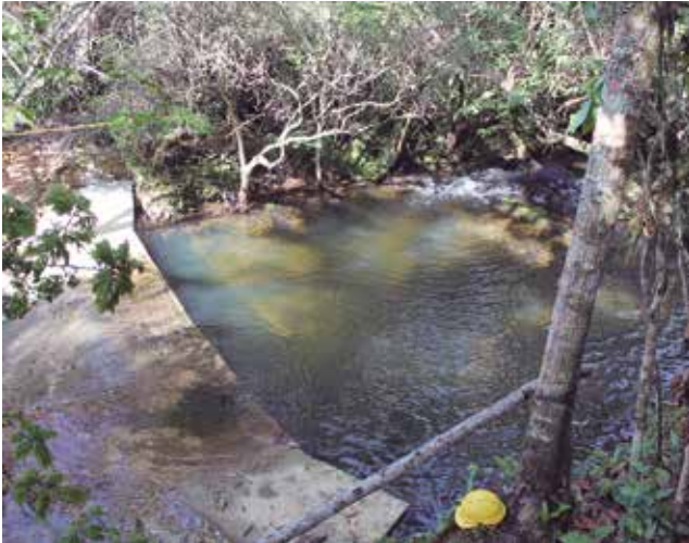
Bocatomas sobre el cauce de la curiti.
