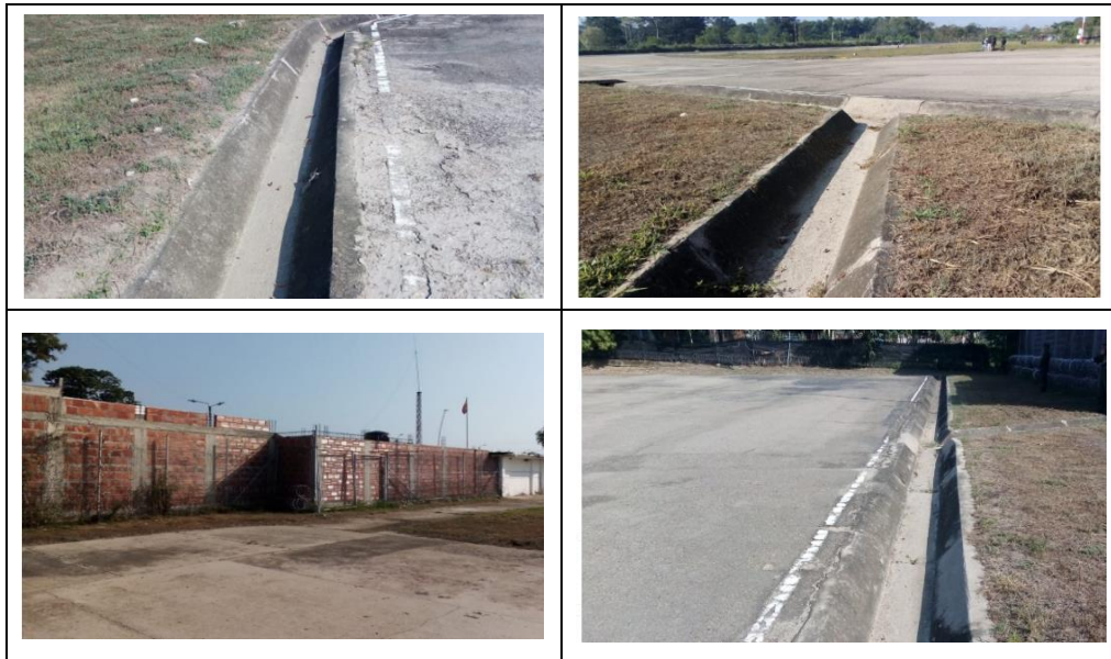
Fotografía 2.4-13 Registro fotográfico base Tibú
