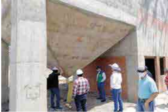
Detalle de avance de obra PTAR Curití.
